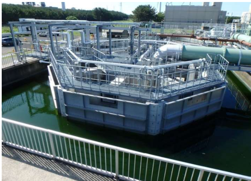
下水処理施設 高効率固液分離設備 高速ろ過装置
