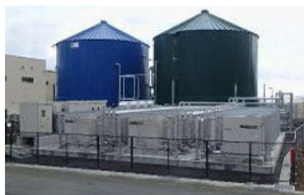
有機物未利用エネルギー活用 バイオマス消化ガス発電設備
