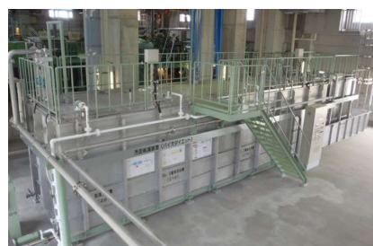
下水処理施設 汚泥削減装置 (バイオダイエット)
