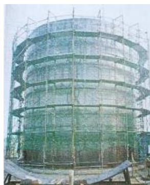
タンク据付工事
