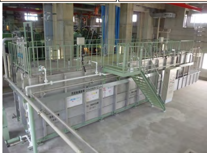
登別市若山浄化センター殿汚泥削減装置
